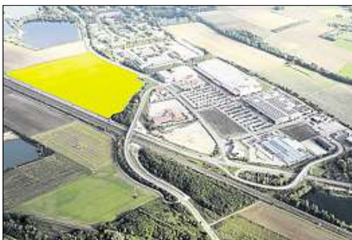
Für ein großes Möbelhaus reserviert: Um die gelb markierte Fläche beim Gewerbegebiet Weiherfeld (rechte Bildmitte, hinten die frühere Immelman-Kaserne) geht es bei den Verhandlungen. Foto: Schalles
